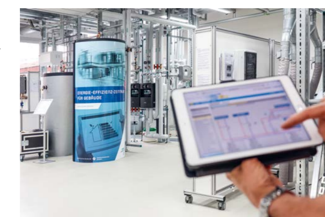
Die neu eingerichtete Fachwerkstatt gilt mit 126 Schulungsständen und Ausstattungsobjekten als hochmodernes Demonstrationszentrum für Energieeffizienz. Foto: Handwerkskammer Dresden
