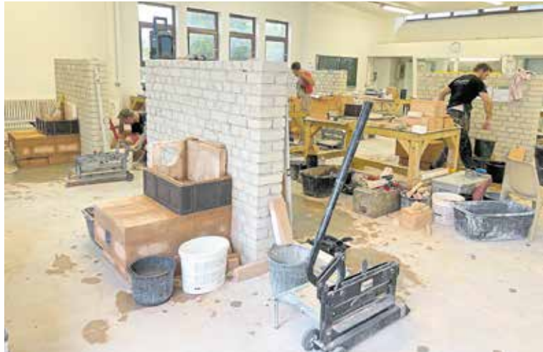
Als Teil der praktischen Prüfung mussten die angehenden Meister im Ofen- und Luftheizungsbaueinzelhandwerk einen Kachelofenteil mit beheizter Sitzbank und Rückenlehne bauen. Foto: Handwerkskammer Dresden
